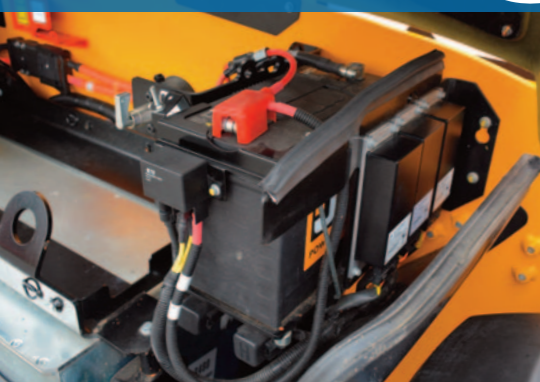
Batteria di servizio
